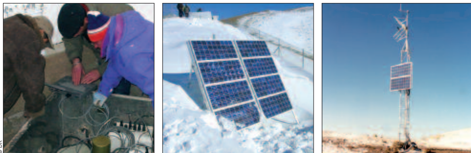
Cette station sismique en Mongolie fonctionne en autonome grâce à des panneaux solaires et un relais satellite.
